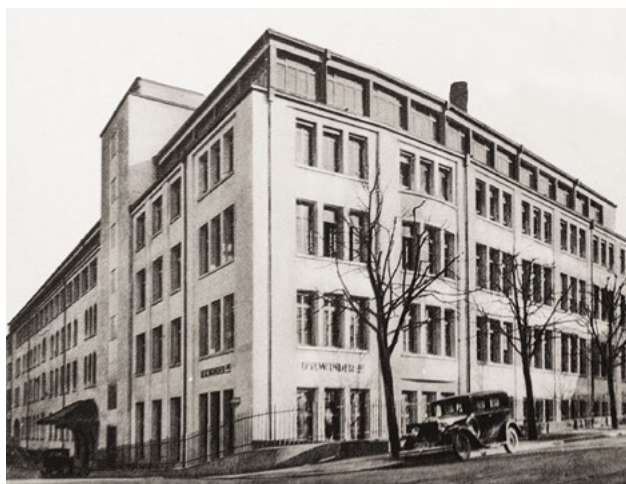
Das wiederaufgebaute Gebäude.
